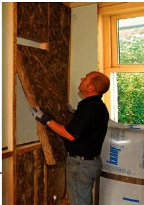
sistema si viene a creare un'intercapedine isolante all'interno della parete che è in grado di abbassare notevolmente la trasmissione di freddo o di calore e anche del rumore.
