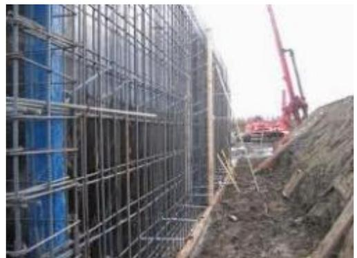
consiste forti barre d'acciaio legate fra di loro e sagomate allo scopo inserite dentro le colate di cemento.
